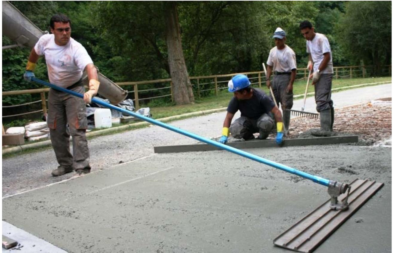
4. Alisar la superficie de hormigón fresco con talocha de magnesio para abrir poro
