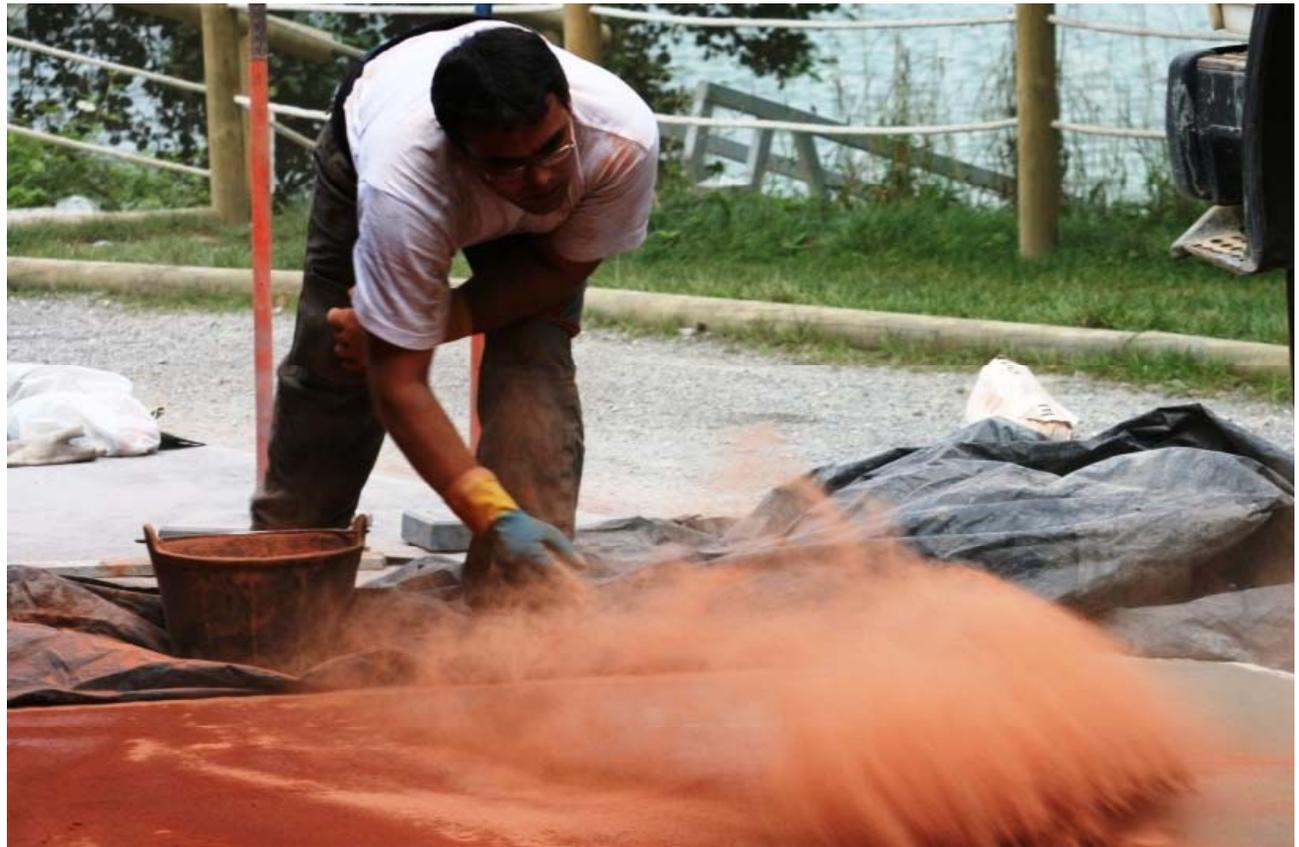
5. Aplicar **ankare zeline** (capa rodadura) 4-6 kgs/m<sup>2</sup> y alisar con llana para fijar el color en dos o tres veces
