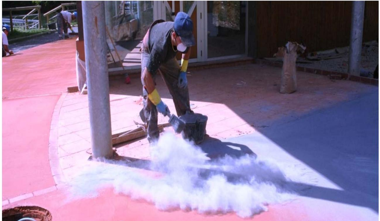
8. Aplicar **ankare desmo** 1 kg/10 m<sup>2</sup> con cepillo de cerdas duras para evitar que el hormigón aún fresco se pegue en los moldes al ser retirados
