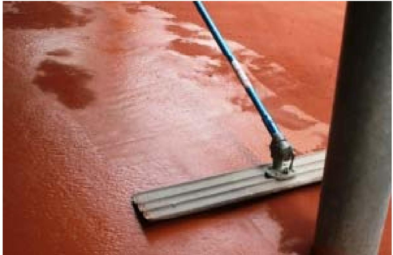
6. Incorporar la capa de rodadura con talocha de magnesio a la superficie del hormigón en dos/tres veces hasta que está esté saturada de capa de rodadura por igual
