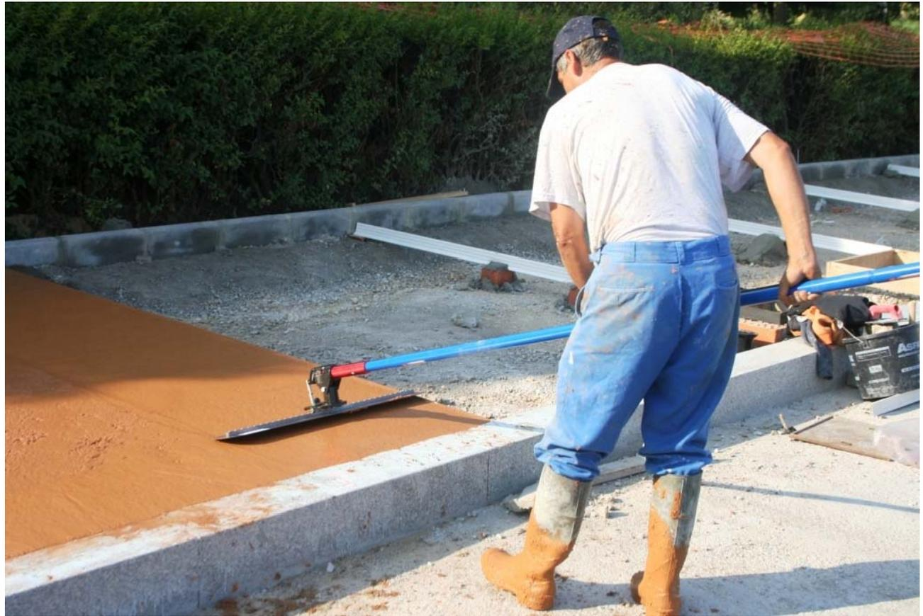
5. Alisar la superficie de hormigón fresco con llanas de acero
